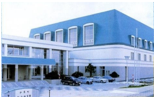
和寒総合体育館全景
